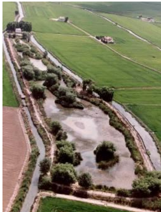
Algemesí reserve, 6 χρόνια μετά την έναρξη των εργασιών αποκατάστασης (Φωτογραφία CCEDCV)
