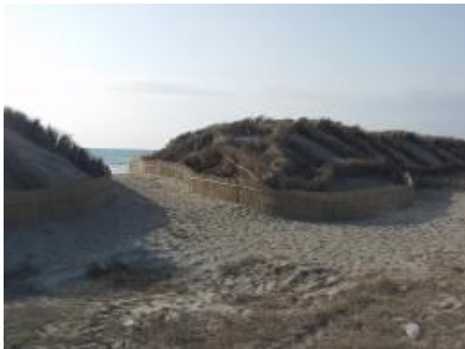
Τοποθετημένα «φράγματα» (Φωτογραφία Devesa-Albufera Service)
