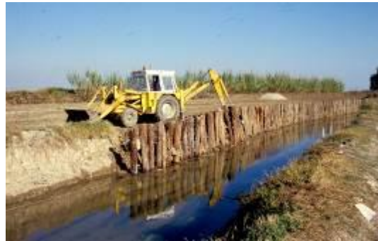
Τοίχος με φυσικά υλικά για την προστασία του πρανούς στο εξωτερικό κανάλι του υγροτόπου (Φωτογραφία CCEDCV)
