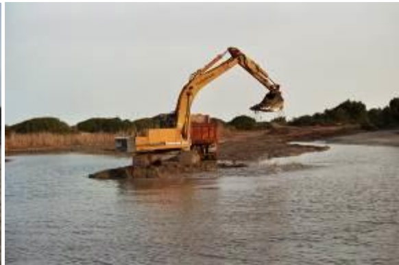
Εργασίες για την αποκατάσταση της μιας λιμνοθάλασσας (Φωτογραφία Devesa-Albufera Service)
