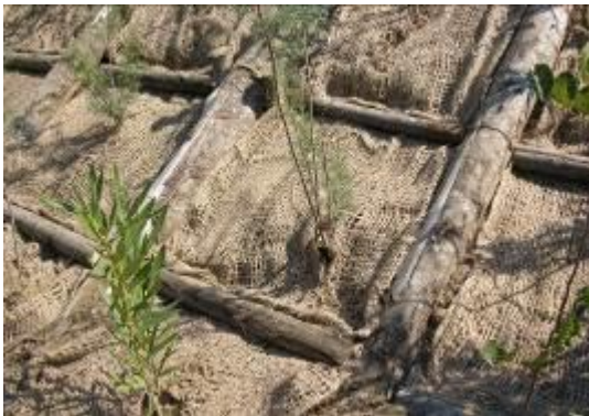
Θέση A: φυτεία στα κελιά ειδικής ξύλινης κατασκευής (Φωτογραφία Enpas)
