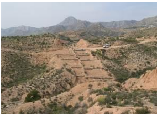
Πρώτα βήματα στην αποκατάσταση εδάφους που είχε διαβρωθεί λόγω του αγωγού: μικρές πέτρινες τοιχίδες (Φωτογραφία Alberto Vilagrosa)
