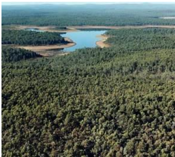
Η ίδια περιοχή μετά την αποκατάσταση (Φωτογραφία Alcoa World Alumina Australia)
