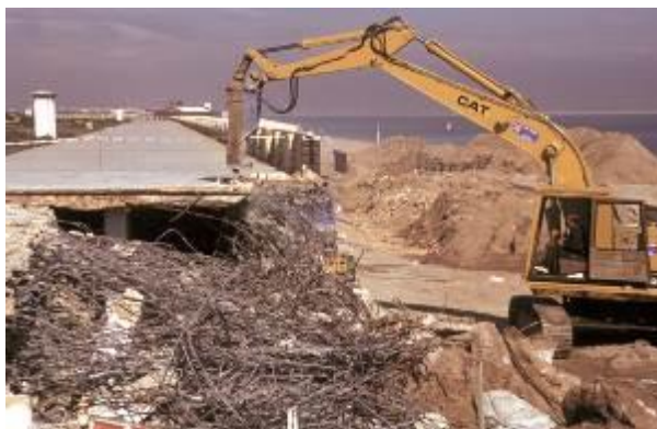
Κατεδάφιση παλιών υποδομών (Φωτογραφία Devesa-Albufera Service)
