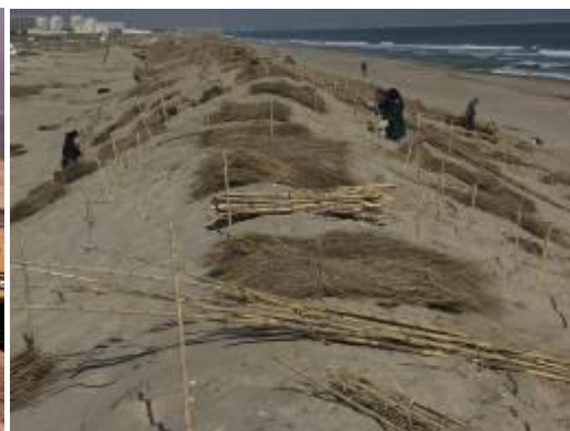
Κατασκευή φραγμάτων για συγκράτηση της άμμου (Φωτογραφία Devesa-Albufera Service)
