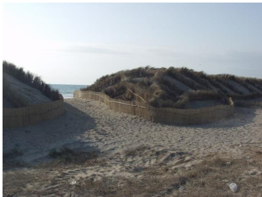
Palisades réalisée (Auteur: Devesa-Albufera Service)
