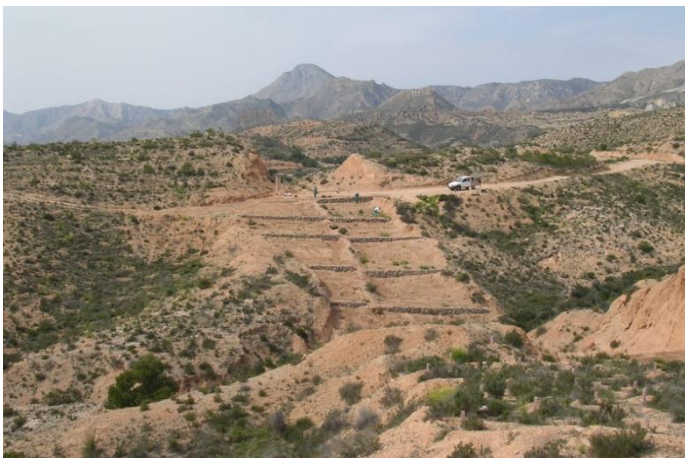
Les premières étapes de restauration par ajustement des pentes avec de petits murs de pierre (Auteur: Alberto Vilagrosa)
