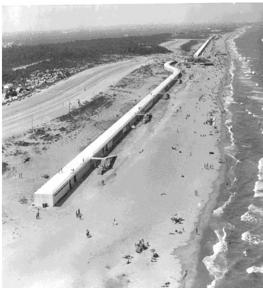
Site du projet avant restauration (Auteur: Devesa-Albufera Service)
