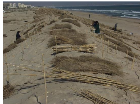
Construction des systèmes de palissades (Auteur: Devesa-Albufera service)
