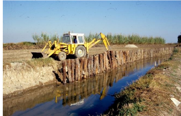
La construction d'un mur avec des matériaux naturels pour soutenir la pente dans le canal externe de la zone humide (Auteur: CCEDCV)
