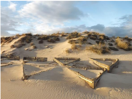
Des structures pour retenir les sables (Auteur: Martino Orrù)
