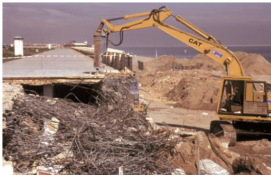
Démolition de l'infrastructure précédente (Auteur: Devesa-Albufera Service)
