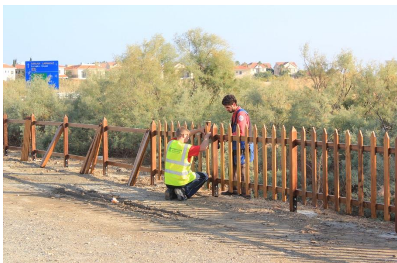
Travaux de clôture (Auteur: M. APOSTOLIDOU ©)
