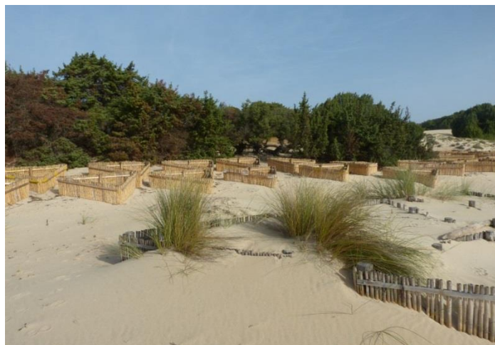
Des structures pour retenir les sables et la végétalisation des dunes : Elymus farctus (Auteur: Martino Orrù)
