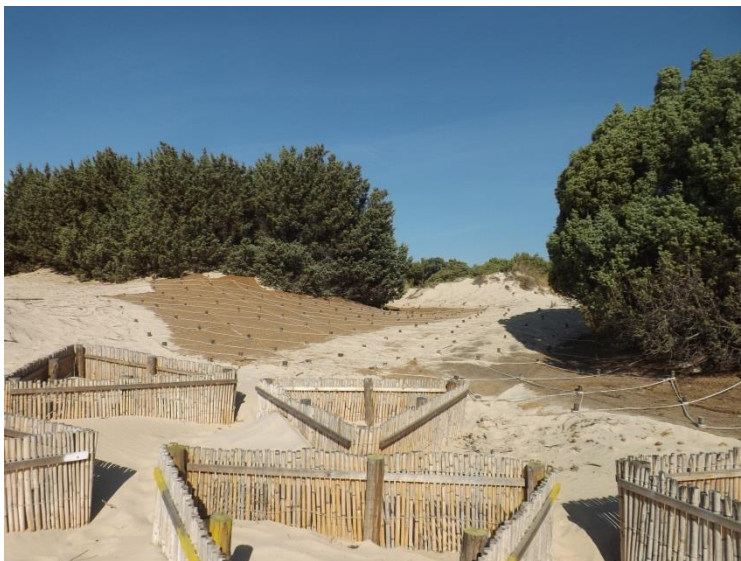
Conservation de l'environnement: les structures pour retenir les sable et les treillis de fibre de coco (Auteur: Martino Orrù)
