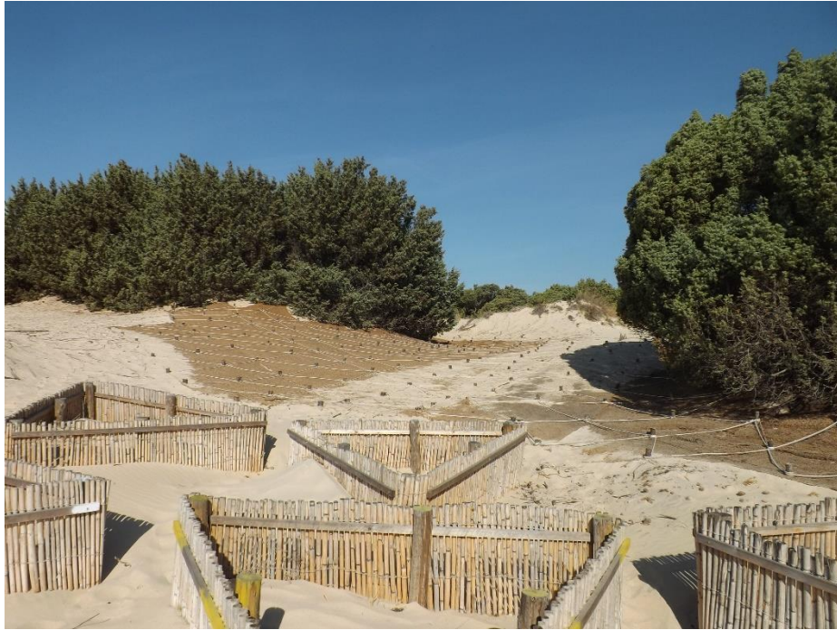
Azioni di conservazione ambientale sul campo: strutture di contenimento della sabbia e maglie in fibra di cocco (Autore: Martino Orrù)
