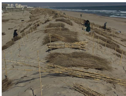
Costruzione dei sistemi di palizzata (Autore: Devesa-Albufera Service)
