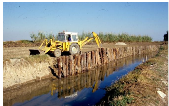
Parete realizzata con materiale naturale per la protezione dell'argine del canale della zona umida (Autore: CCEDCV)
