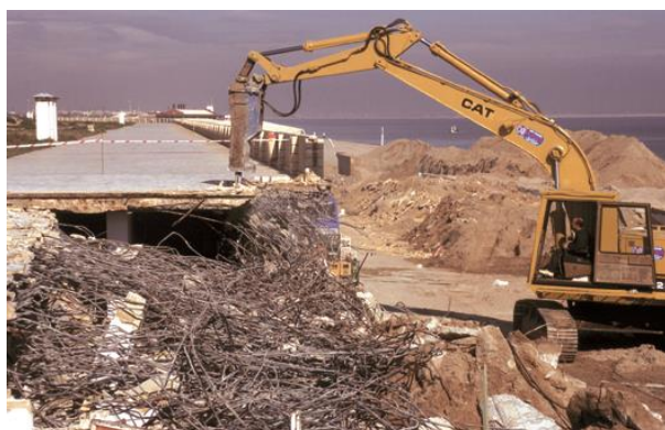
Demolizione delle infrastrutture del passato (Autore: Devesa-Albufera Service)
