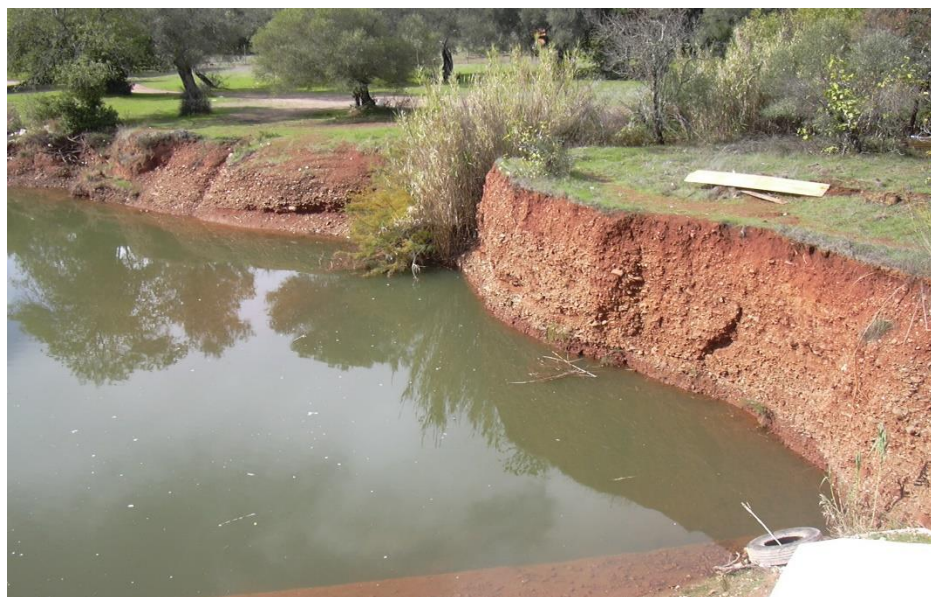
Argine destro del rio Gutturreddu (Autore: Enas)
