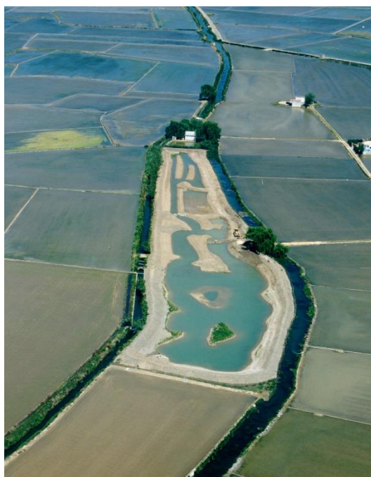
Riserva di Algemés, prima fase di ripristino (Autore: CCEDCV)
