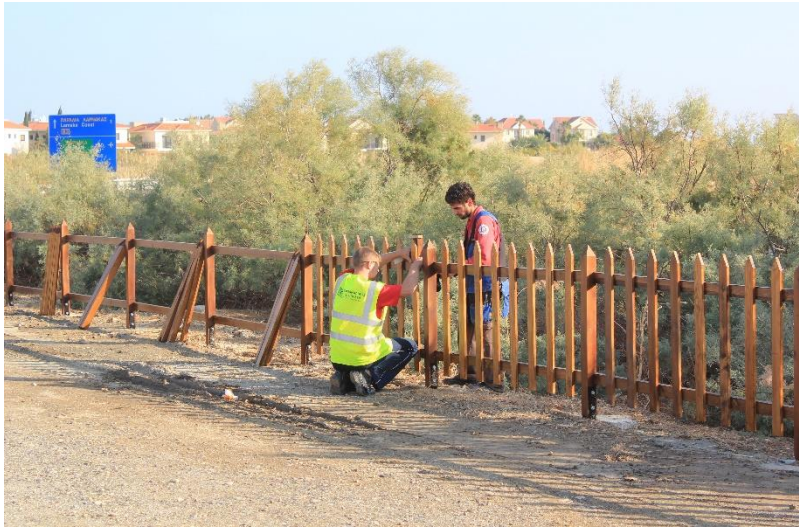
Costruzione dei recinti (Autore: M. Apostolidou©)
