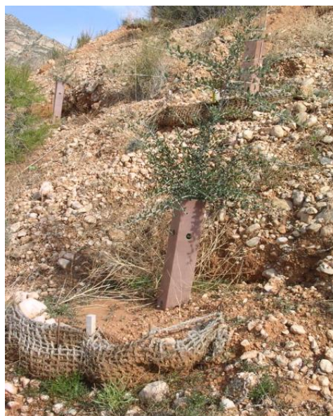
Olea europaea var. sylvestris su una terrazza individuale con un micro-bacino, e rete in juta come protezione dall'erosione (Autore: Alberto Vilagrosa)
