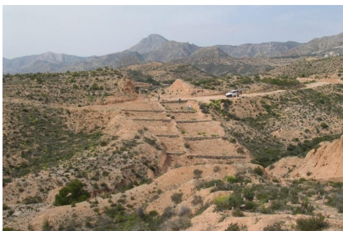
Primi passi nel ripristino di un'area interessata da canalizzazioni: sistemazione dei pendii con piccoli muri di pietra (Autore: Alberto Vilagrosa)
